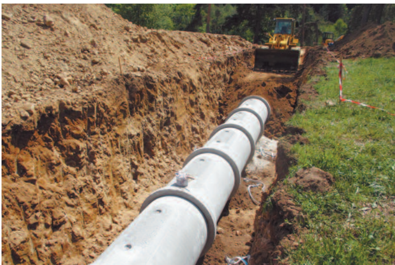
Réseau d'assainissement - ZA de Rascles (St-Agrève)
