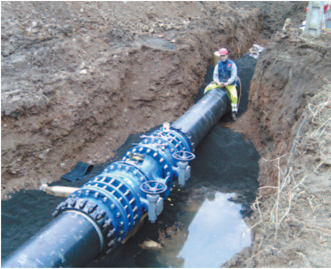
Adduction d'eau - Ø 600 - La Fouillouse (42)
