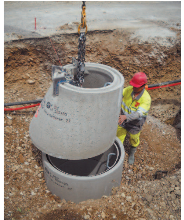
Pose d'un regard d'eaux usées - Suze-la-Rousse (26)
