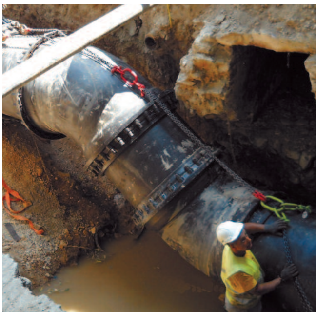
Adduction d'eau potable - Ø 1000 - Cassis (13)
