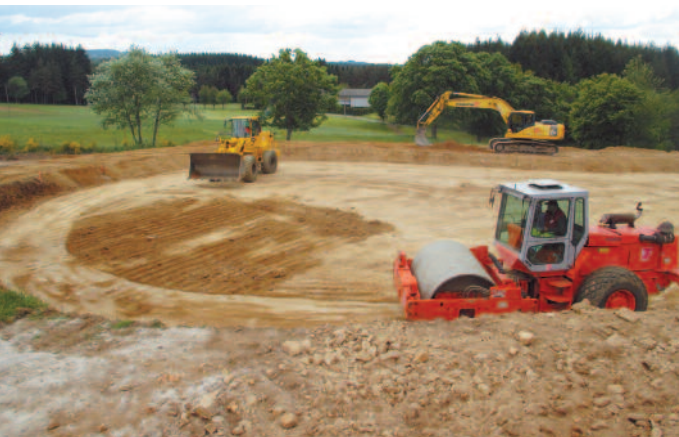
Terrassement - ZA de Rasclès (St-Agrève)
